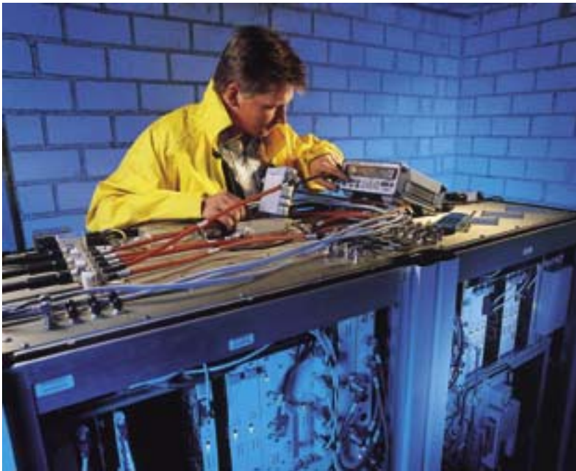
NRT в процессе установки базовой станции для мобильной радиосвязи
